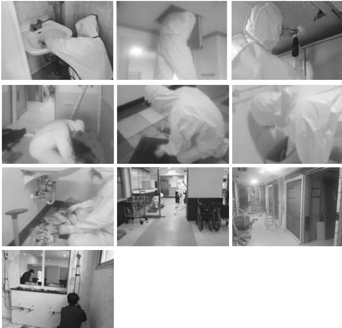
[그림 3-2-23] 기타 시설 보수
