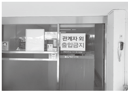
1층 사인물 설치
