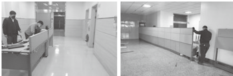
1층 화장실 파티션 구획모습
