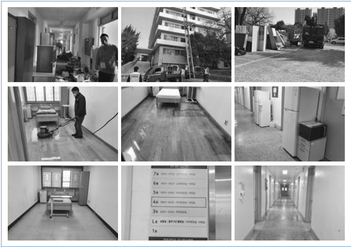
[그림 3-2-25] 구병동 설치 작업
