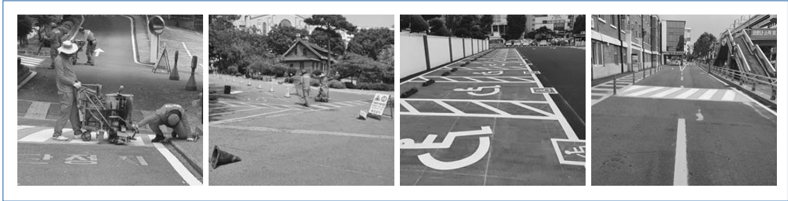
[그림 3-2-37] 원내 도로 아스콘 포장 작업 및 차선 도색 작업
